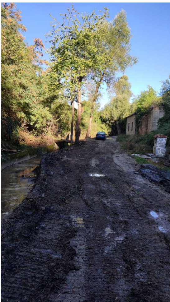
Φωτογραφία 5. Καθαρισμός χώρου ελέγχου και ρέματος, δίπλα από τον αγροτικό χωματόδρομο (ολοκλήρωση εργασιών 28-09-2026)
