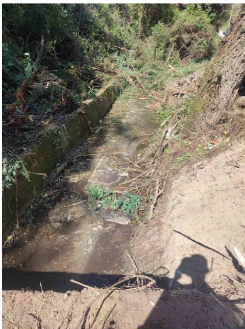
Φωτογραφία 4. Κατά τη διαδικασία καθαρισμού του ρέματος.
