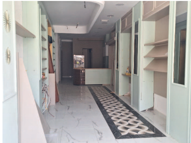
Φωτογραφία 4. Εσωτερικό καταστήματος - Λήψη 02/04/2024.
