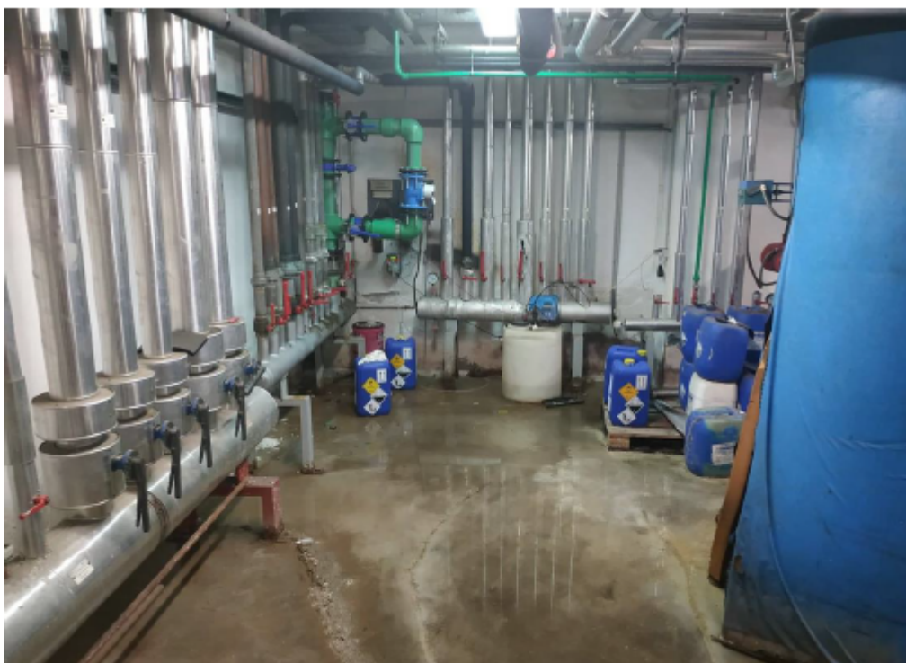
Λεβητοστάσιο Νοσοκομείου Γρεβενών
