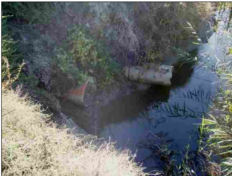
Φωτ. 3.8. Άποψη αγωγών PVC μικρής διαμέτρου κάτω από υφιστάμενο ανάχωμα (Ημ. λήψης 15/9/2008).
