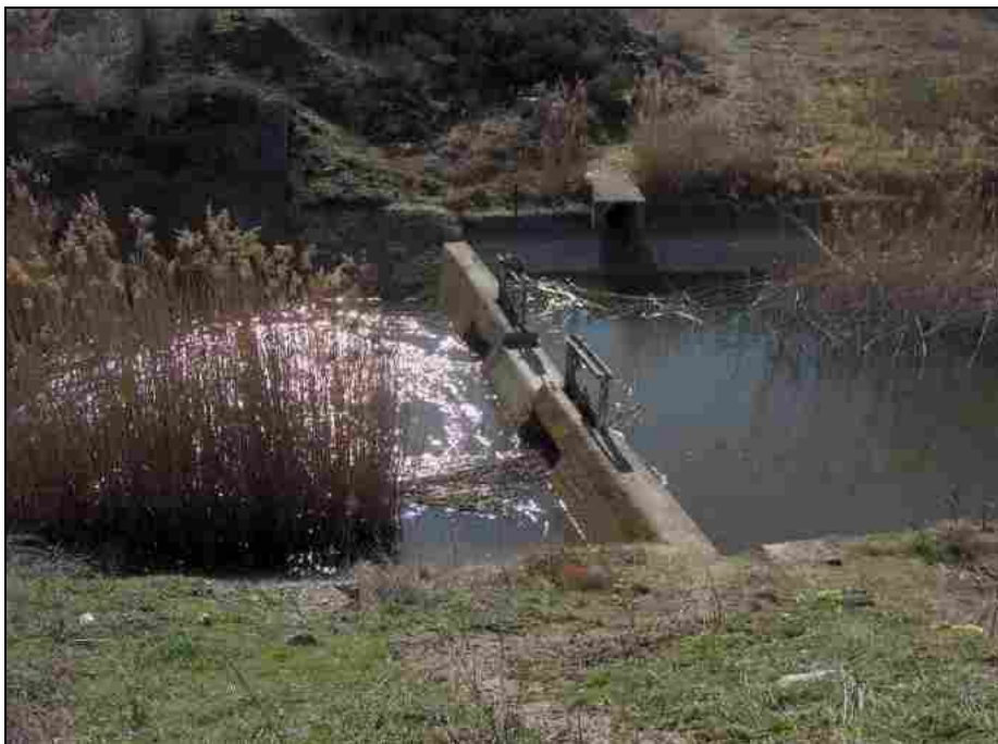
Φωτ. 3.1: Άποψη του θυροφράγματος στην περιοχή του Ροδώνα (Ημ. λήψης 21/3/2006).
