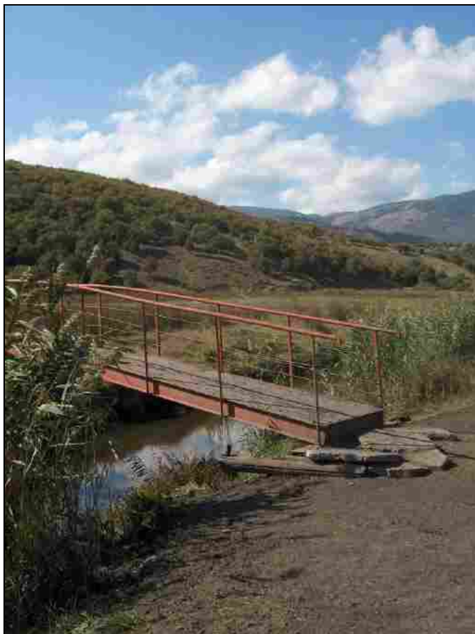
Φωτ. 3.12. Άποψη μεταλλικής πεζογέφυρας (Ημ. λήψης 1/10/2008).
