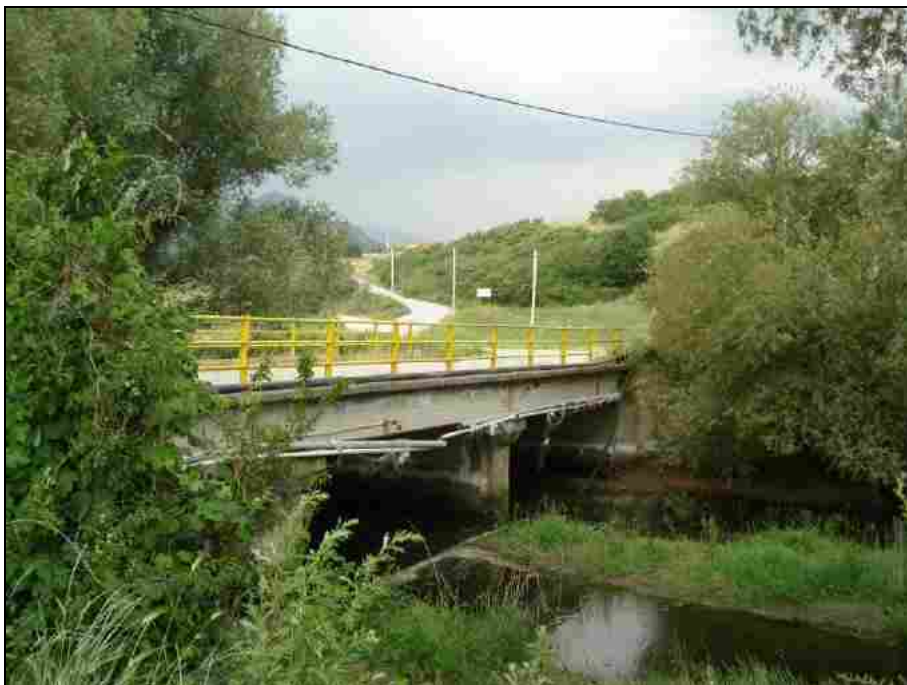
Φωτ. 3.9. Άποψη της εκτροπής του ρ. Σκλήθρου στη γέφυρα Ε.Ο. Αετού – «Μπάνια» (Ημ. λήψης 2/6/2008).
