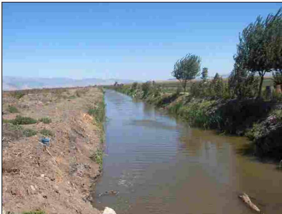
Φωτ. 3.2: Άποψη της κεντρικής αποστραγγιστικής τάφρου πλησίον της υπερχείλισης της λ. Χειμαδίτιδας (Ημ. λήψης 15/9/2008).
